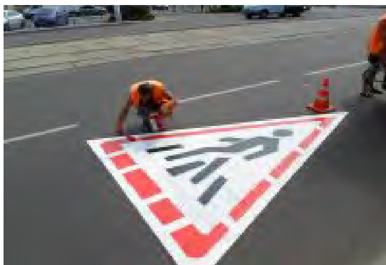
Рисунок 17 – Дублювання на покритті знака «Пішохідний перехід»
