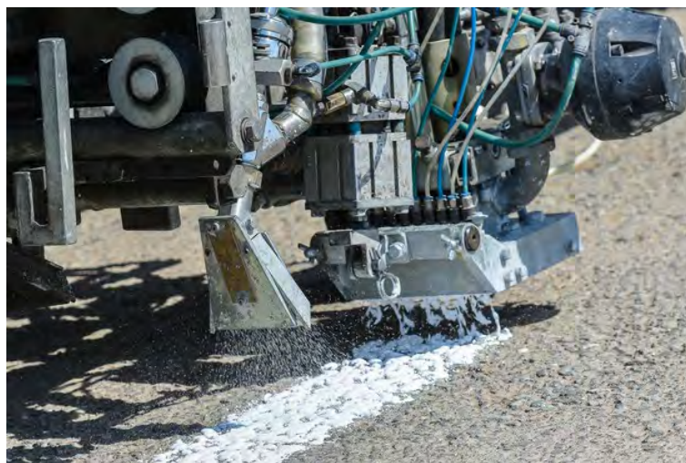
Рисунок 8 – Нанесення холодного пластику на дорожнє покриття машинним способом
