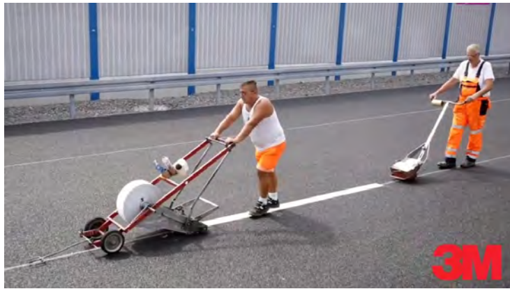
Рисунок 23 – Нанесення на покриття полімерної стрічки, на якій вже є клейовий шар ручним візком-аплікатором
