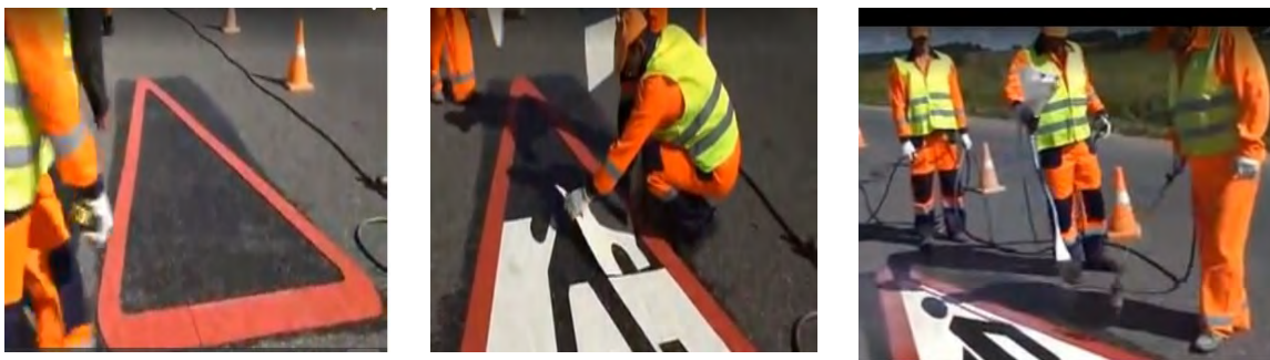
Рисунок 18 – Етапи нанесення дублюючого знаку «Пішохідний перехід» готовими термопластичними формами
