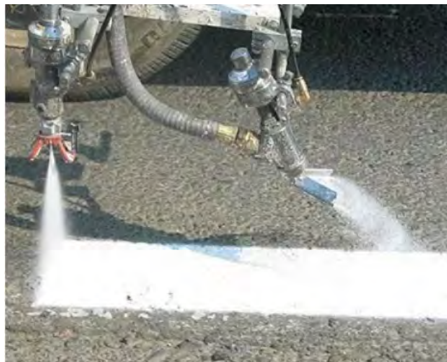
Рисунок 10 – Нанесення дорожньої фарби та склокульок на дорожнє покриття
