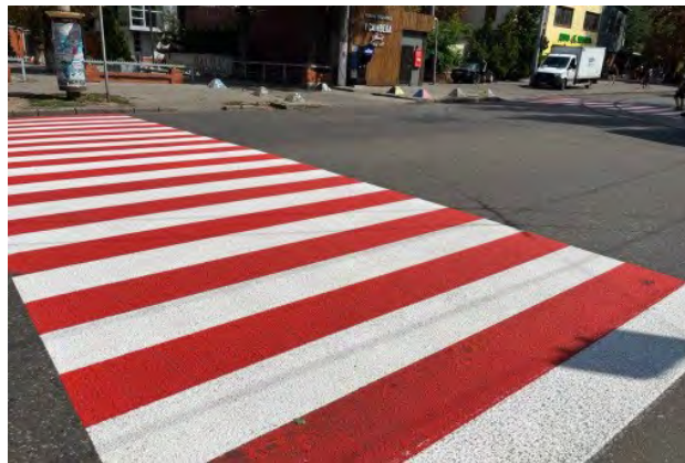
Рисунок 34 – Дорожня розмітка червоно-білого кольору на пішохідному переході
