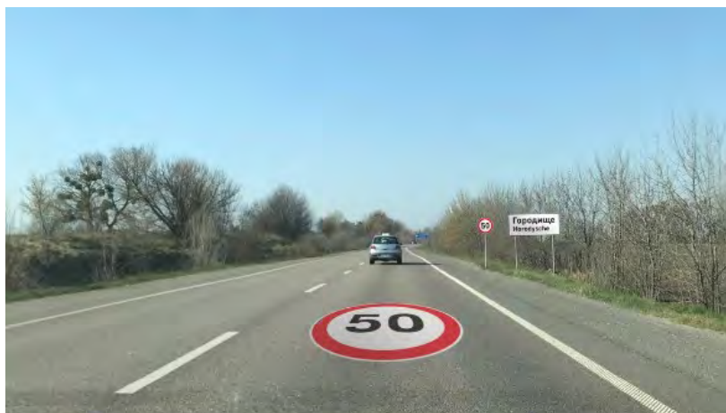
Рисунок 16 – Дублювання на покритті знака «Обмеження максимальної швидкості»
