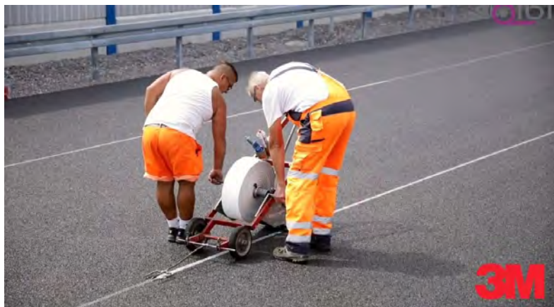
Рисунок 22 – Встановлення рулону в ручний візок-аплікатор
