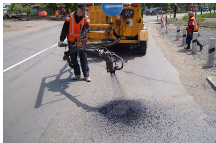
Рисунок 6 – Ямковий ремонт струменево-ін'єкційним методом
