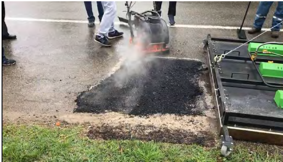
Рисунок 20 – Ущільнення вибоїни
