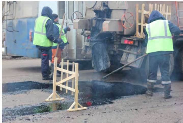
Рисунок 5 – Ямковий ремонт литим асфальтобетоном
