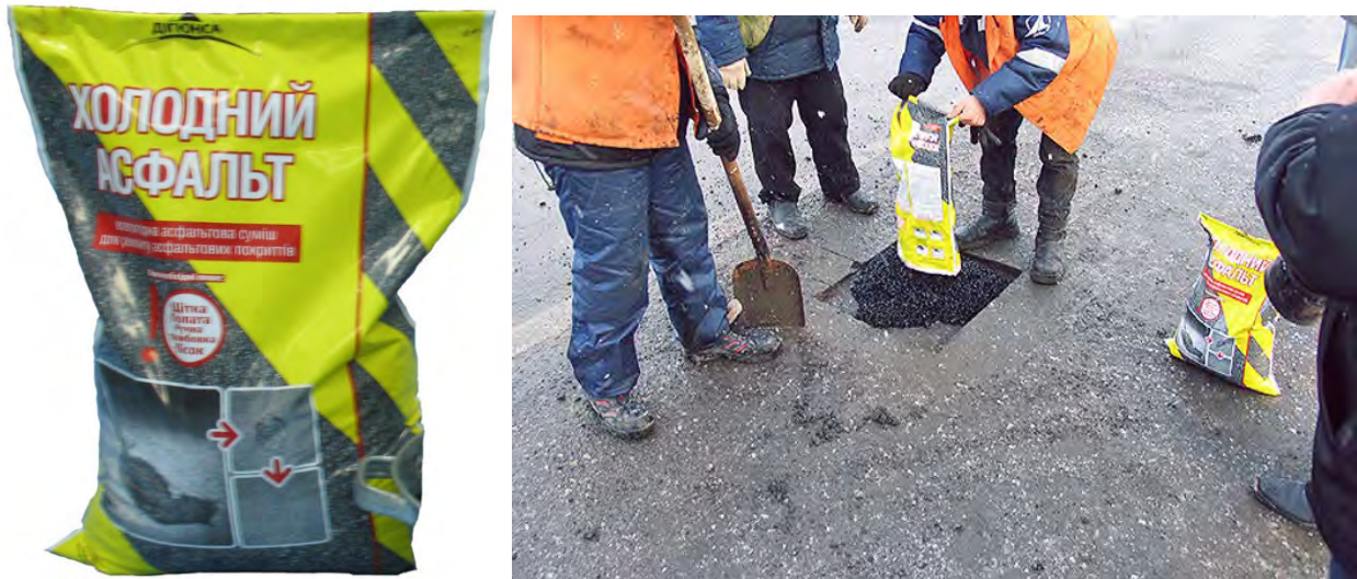
Рисунок 4 – Ямковий ремонт холодною асфальтобетонною сумішшю
