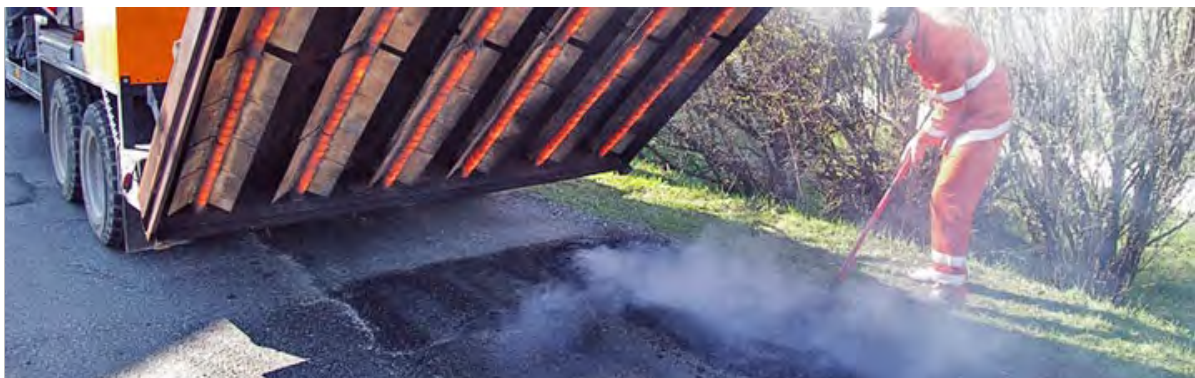
Рисунок 19 – Розпушування граблями на всю глибину вибоїни
