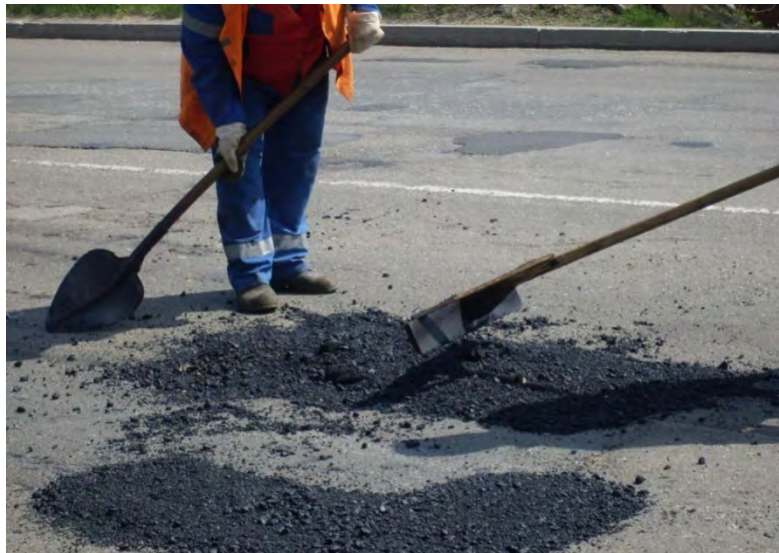
Рисунок 7 – Ямковий ремонт гарячою асфальтобетонною сумішшю
