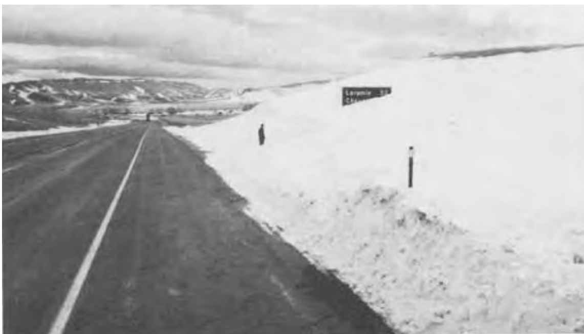
Рисунок 1 – Снігові умови на ділянці дороги до будівництва снігових огорож
