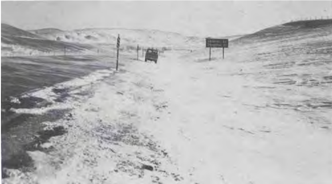
Рисунок 2 – Снігові умови на ділянці дороги після будівництва снігових огорож
