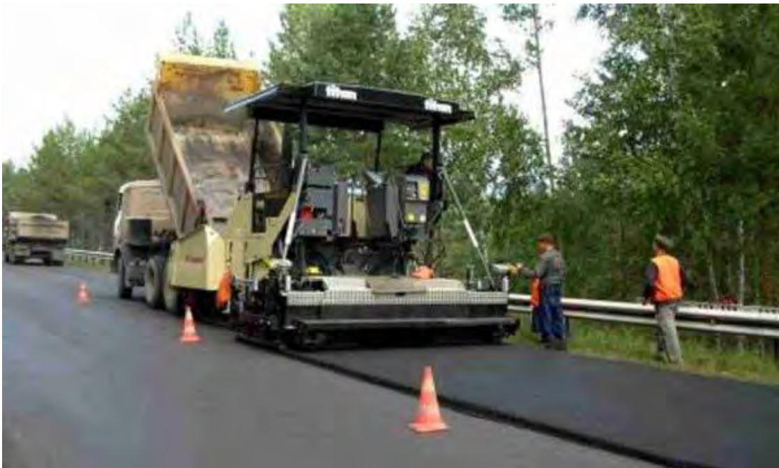
Рисунок 2 – Влаштування покриття одним асфальтоукладачем
