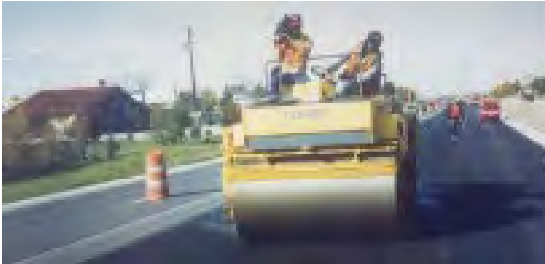
Рисунок 20 – Ущільнення із перекриттям суміжної смуги
