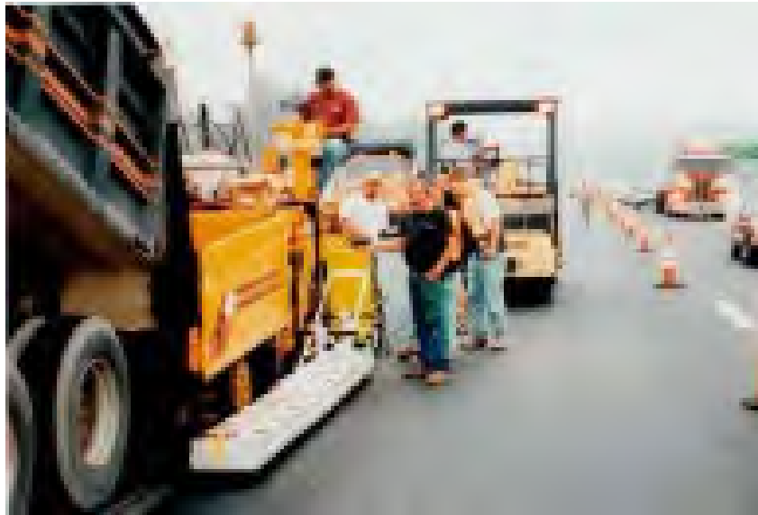
Рисунок 17 – Системи інфрачервоного прогріву на асфальтоукладачі
