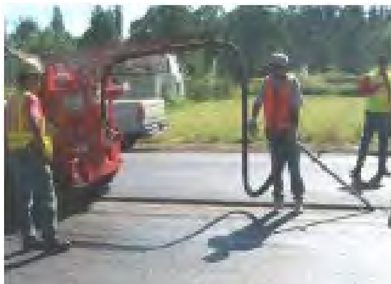
Рисунок 19 – Спеціалізований заливник для нанесення мастики
