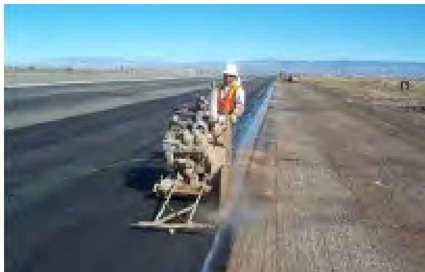
Рисунок 16 – Обрізання кромки алмазним диском
