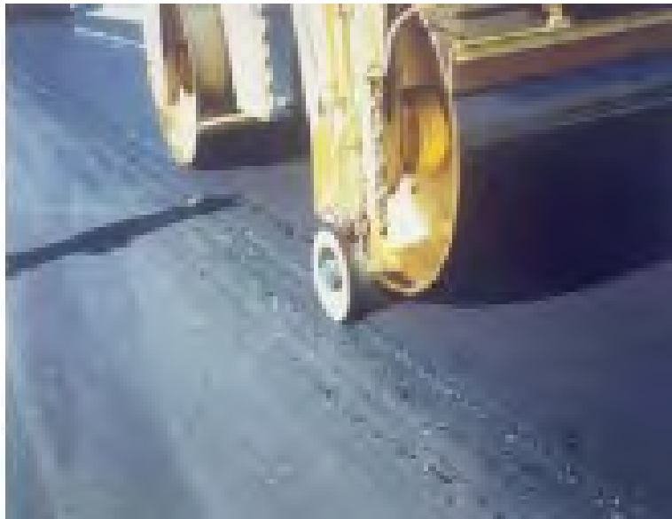
Рисунок 18 – Крайовий ущільнювач на провідному вальці котка
