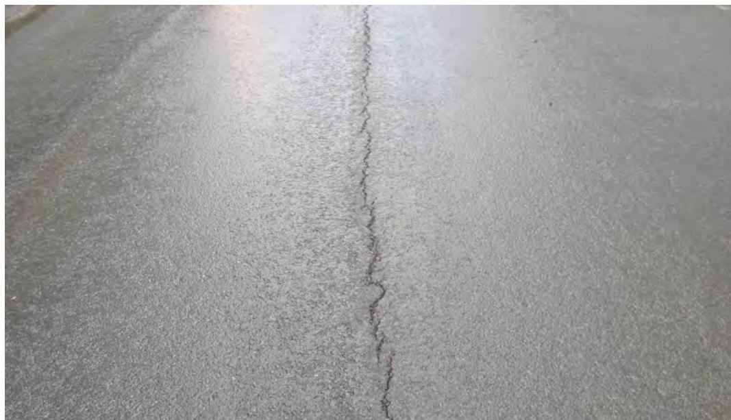
Рисунок 1 – Поздовжня тріщина
