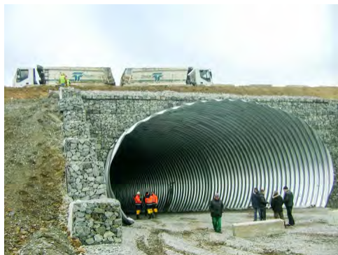
Рисунок 6 – Двоочкова арка на обході смт. Бобринець. Кіровоградська область (СМГК SC – 68R)
