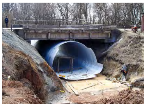
Рисунок 8 – Транспортний тунель на обході м. Одеса (СМГК SUPERCOR SC 87S)
