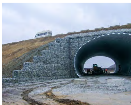
Рисунок 7 – Транспортний тунель на км 228+160 а/д Київ – Харків – Довжанський (СМГК SUPERCOR 87S)
