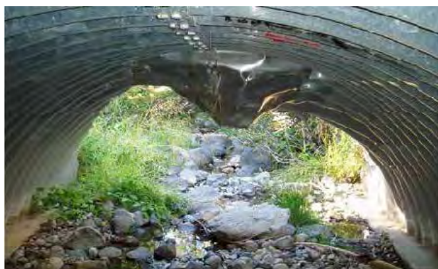
Рисунок 12 – Деформації гофрованих листів МГК
