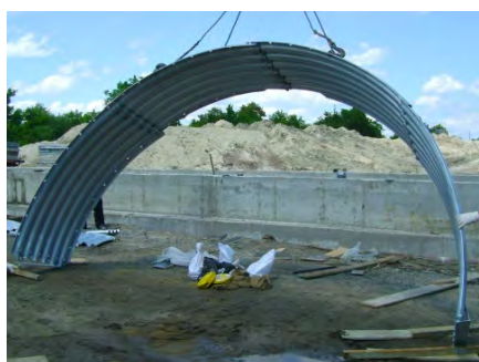
Рисунок 4 – Пішохідний перехід лінією швидкісного трамваю (м. Київ) (Арка Multiplate V-16)
