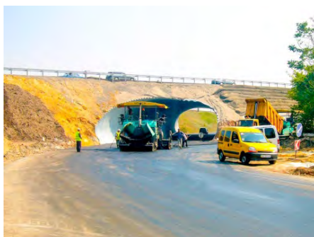
Рисунок 8 – Транспортний тунель на обході м. Одеса (СМГК SUPERCOR SC 87S)
