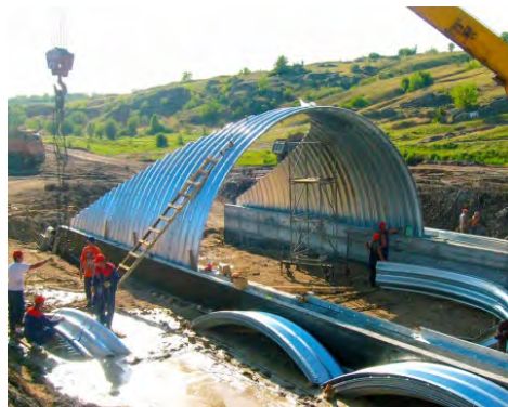
Рисунок 6 – Двоочкова арка на обході смт. Бобринець. Кіровоградська область (СМГК SC – 68R)
