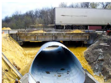
Рисунок 9 – Реконструкція (гільзування) мостового переходу на а/д Київ – Луганськ – Ізварино (СГМК МР200 РА/14)
