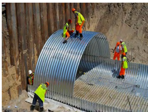
Рисунок 4 – Пішохідний перехід лінією швидкісного трамваю (м. Київ) (Арка Multiplate V-16)
