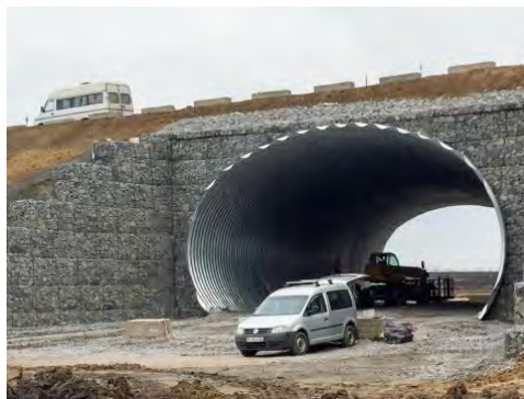
Рисунок 6 – Двоочкова арка на обході смт. Бобринець. Кіровоградська область (СМГК SC – 68R)
