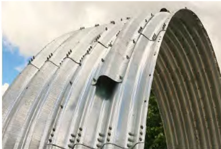
Рисунок 21 – Приклад поєднання гофрованих листів між собою
