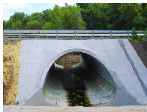
Рисунок 8 – Транспортний тунель на обході м. Одеса (СМГК SUPERCOR SC 87S)
