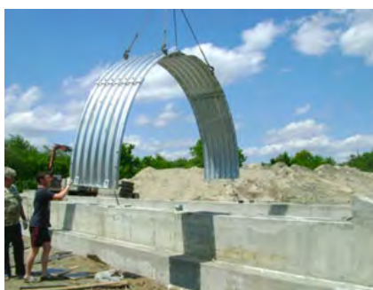
Рисунок 4 – Пішохідний перехід лінією швидкісного трамваю (м. Київ) (Арка Multiplate V-16)
